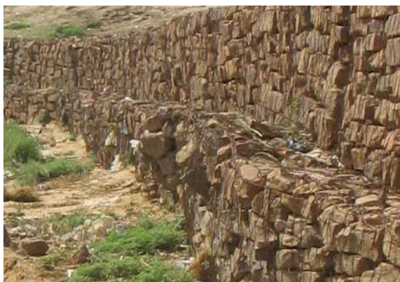
Figure 51: Détail d'un gabionnage (Sofara)
