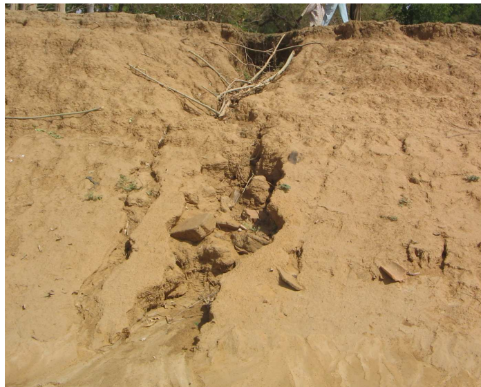
Figure 11 : Dégâts provoqués par le ruissellement (Kara/Diafarabé)
